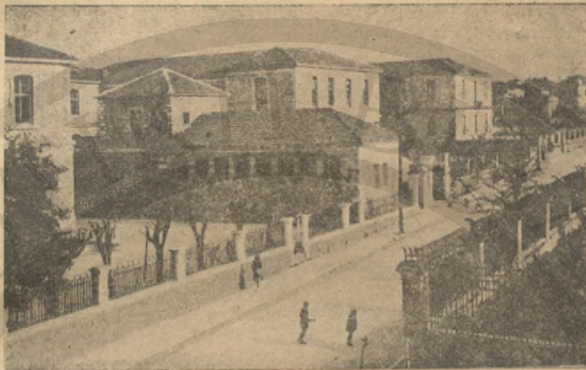
ΤΑ ΣΧΟΛΙΚΑ ΚΤΙΡΙΑ ΧΑΝΙΩΝ ΕΠΙ ΤΗΣ ΟΔΟΥ ΚΟΡΑΗ Διακρίνονται τὸ Β' Γυμνάσιον Χανίων, τὸ Γυμνάσιον Θηλέων καὶ ἡ Ἐμπορικὴ Σχολὴ Χανίων.
