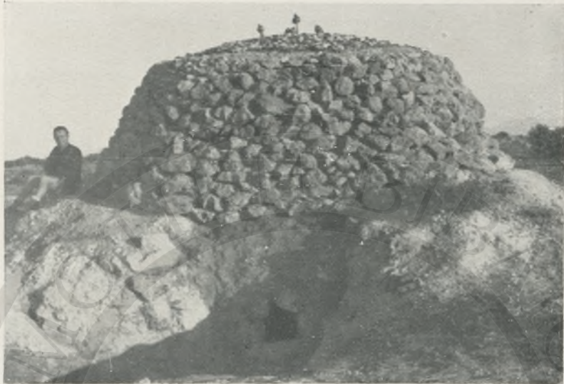
Fig. 35 - Fornace per calce presso Musurà (Acrotiri, Creta Nord-Occ.).
