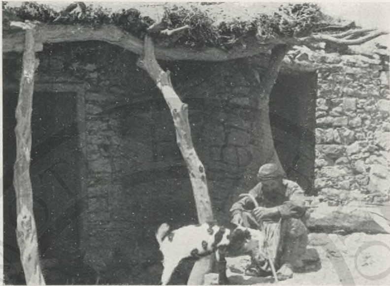
Fig. 13 - Ingresso di abitazione del villaggio di Rusa Pithià (Creta Nord-Or.). Tale ingresso, nonchè la struttura interna ed esterna di questo tipo di abitazione ricordano molto quanto osservarsi negli hudnò dell'Africa Orientale.
