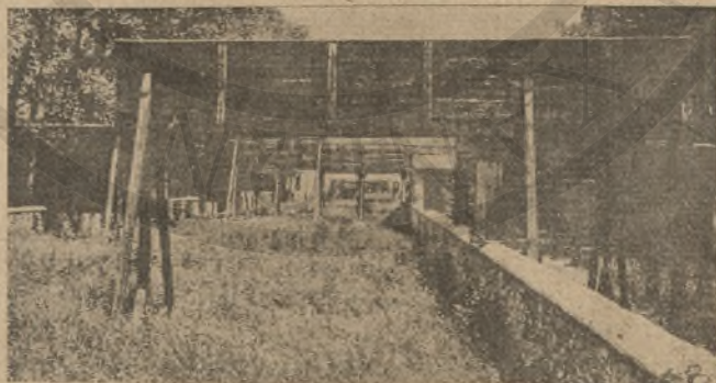
Εἰκὼν 7.— Ἐγκάρσιον προφυλακτήριον, ἐκ χονδρῶν δοκῶν κασιανέας, συναρμολογημένον πρὸς ἀλλήλας.
