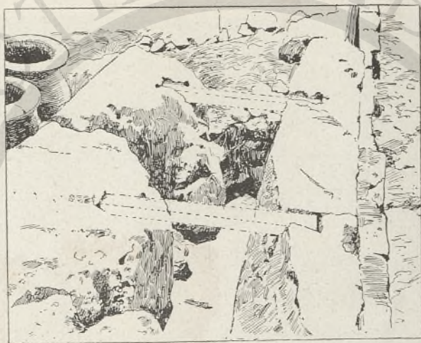
Fig. 55. — Muri a doppia parete, fatti con grandi blocchi congiunti con traverse di legno.
