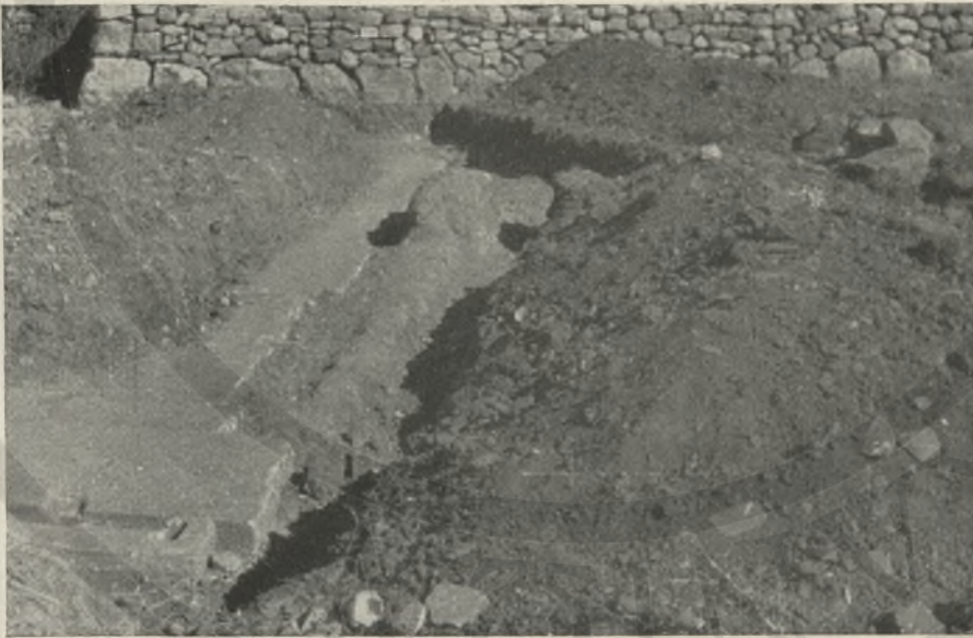
2. Fundament der Front eines Hauses auf der Flur Ta Marmara
