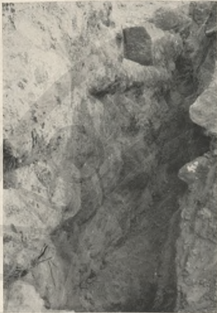
1. Das Eleutherna-Tor, Fundamentierung
