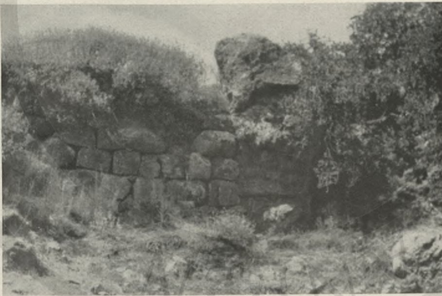
2. Terrassenmauer auf der Stadthöhe von Kerame
