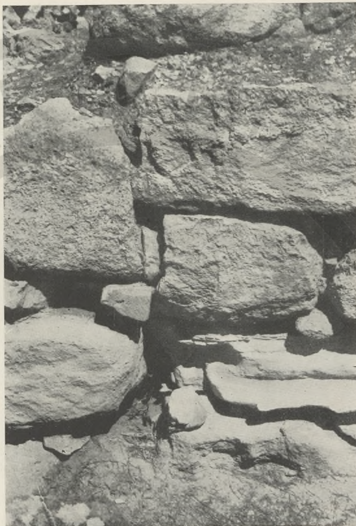
FIG. 75 - ATTACCO DEL MURO OVEST DEL VANO 95 COL MURO A SQUADRA PIÙ RECENTE
