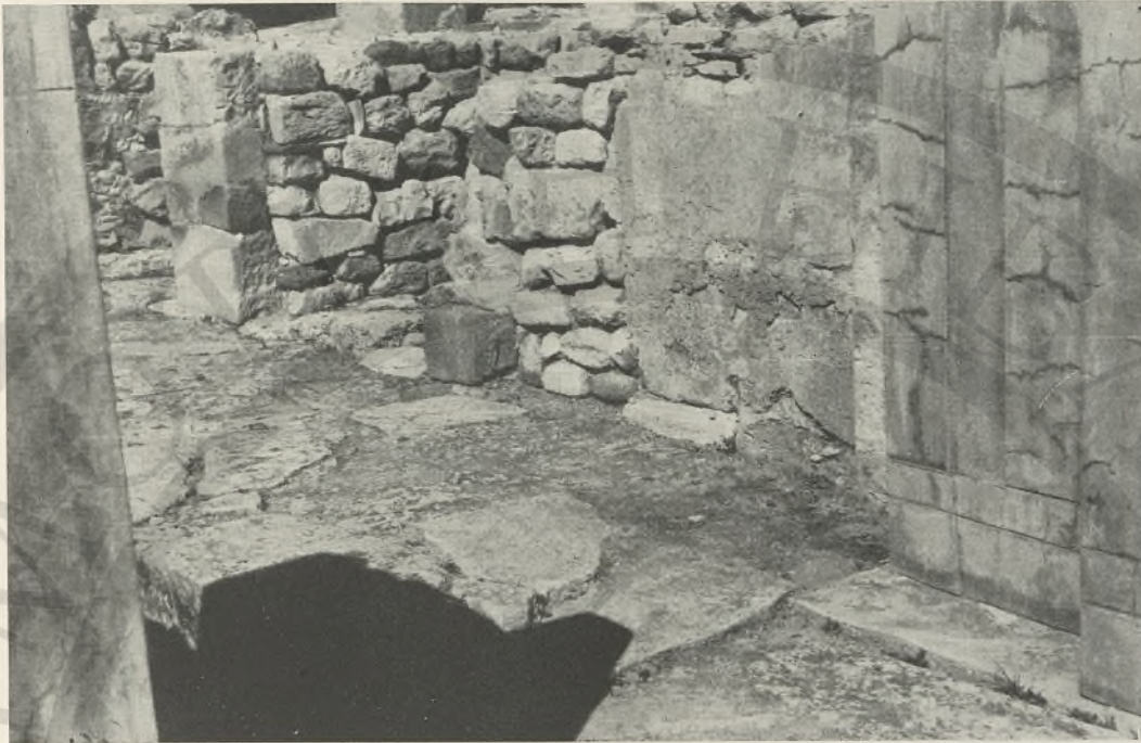
FIG. 141 - CORRIDOIO 41: IL MURO EST DI FRONTE ALLA NICCHIA DIPINTA
