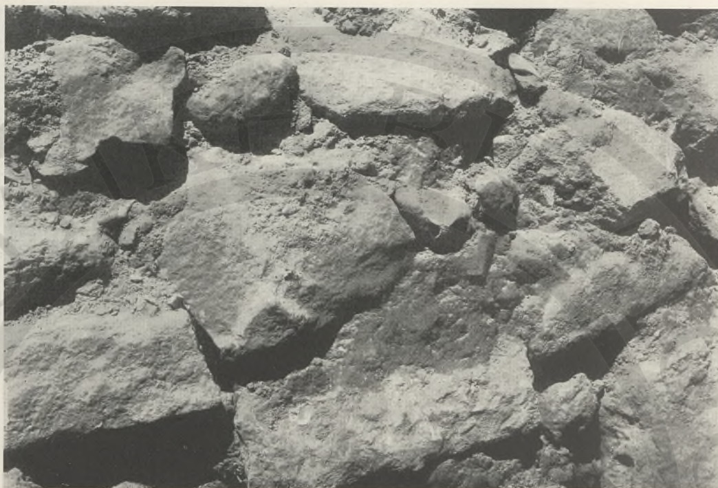
FIG. 203 — FONDAMENTA DELLO STILOBATE DEL PORTICO 69
