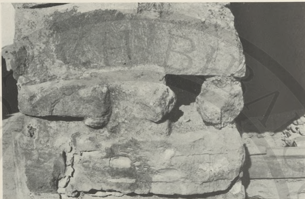
FIG. 50 — BLOCCHI TRASVERSALI DEL MURO 25-38 E FORO DI TRAVE
