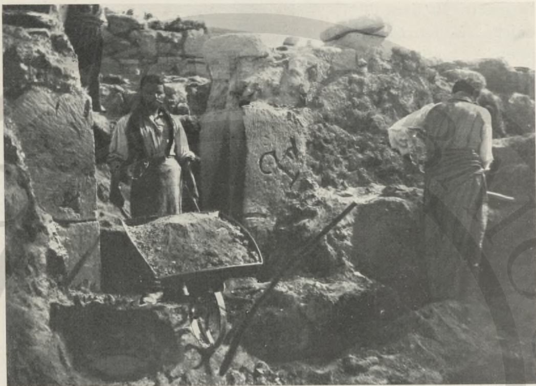
FIG. 42 — SCAVO DEL MAGAZZINO 37
