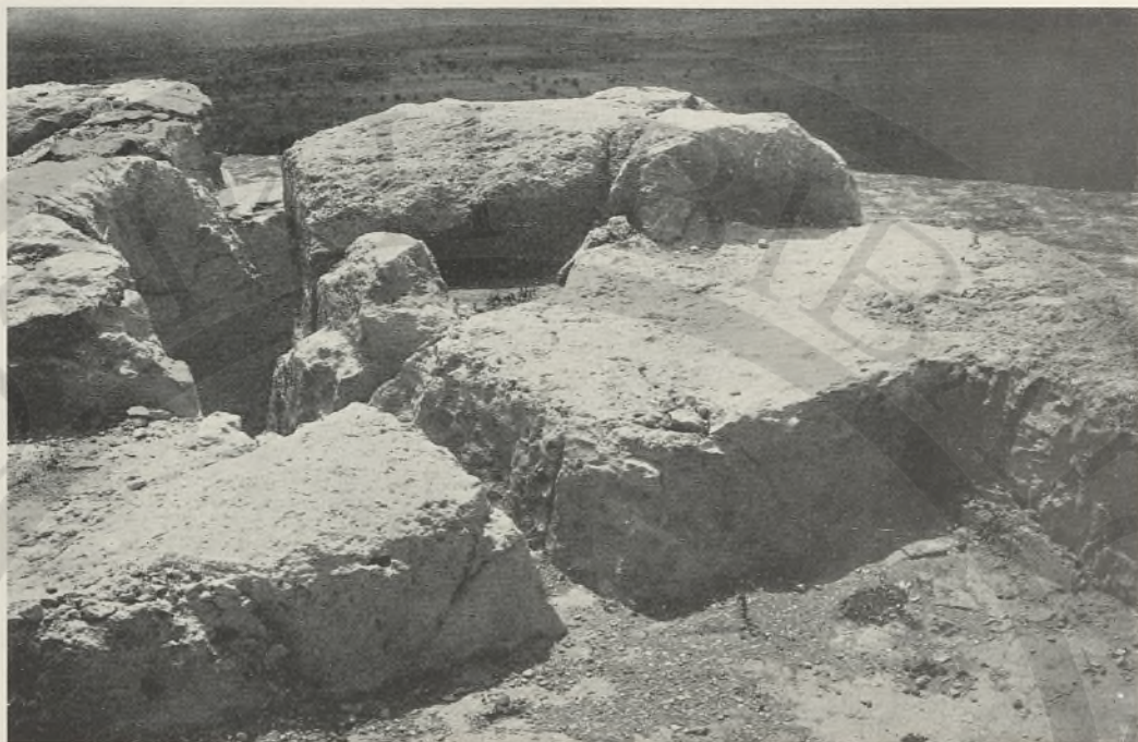
FIG. 110 - TAGLIO DELLA ROCCIA PER LE FONDAMENTA DELLA FACCIATA ORIENTALE E CANALE DI SCARICO
