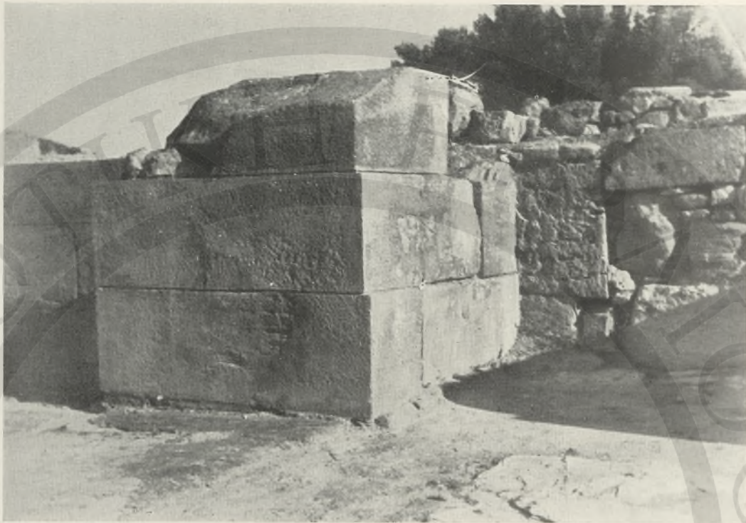
FIG. 199 - PORTICO 68: L'ANTA NORD RESTAURATA
