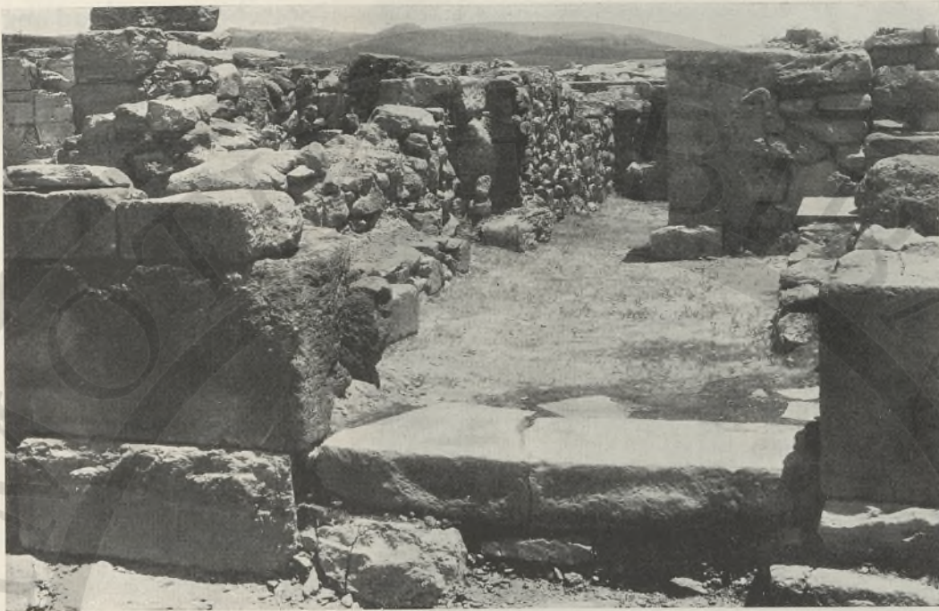
FIG. 59 - VANO 10: INGRESSO DAL CORTILE CENTRALE. IN FONDO PORTA 10-11
