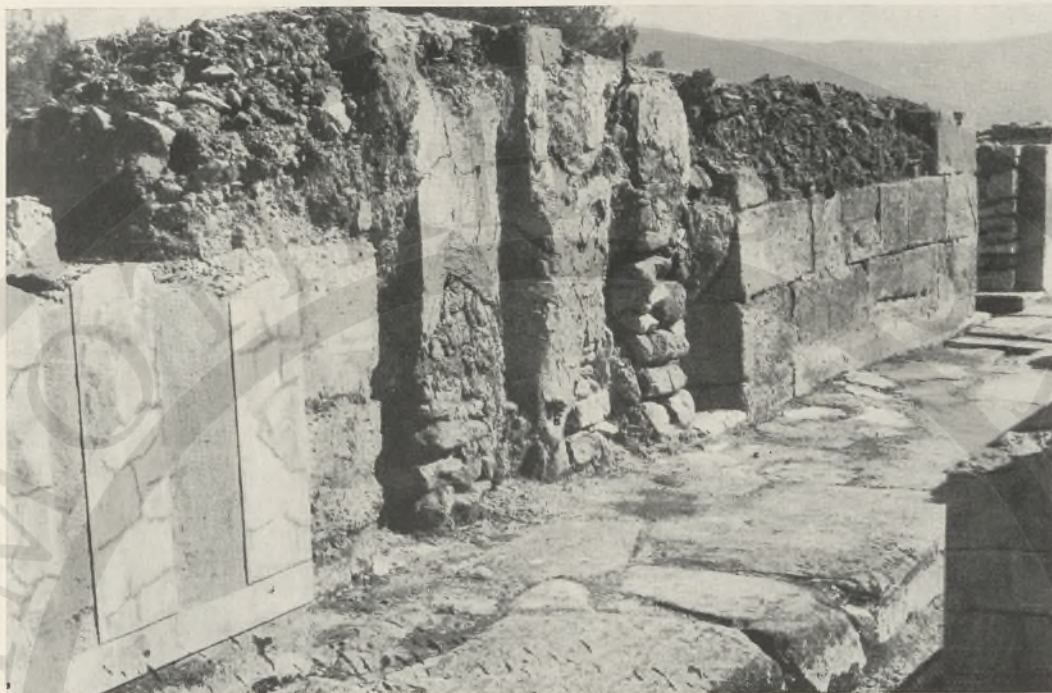
FIG. 136 - CORRIDOIO 41: MURO EST (DA NORD)
