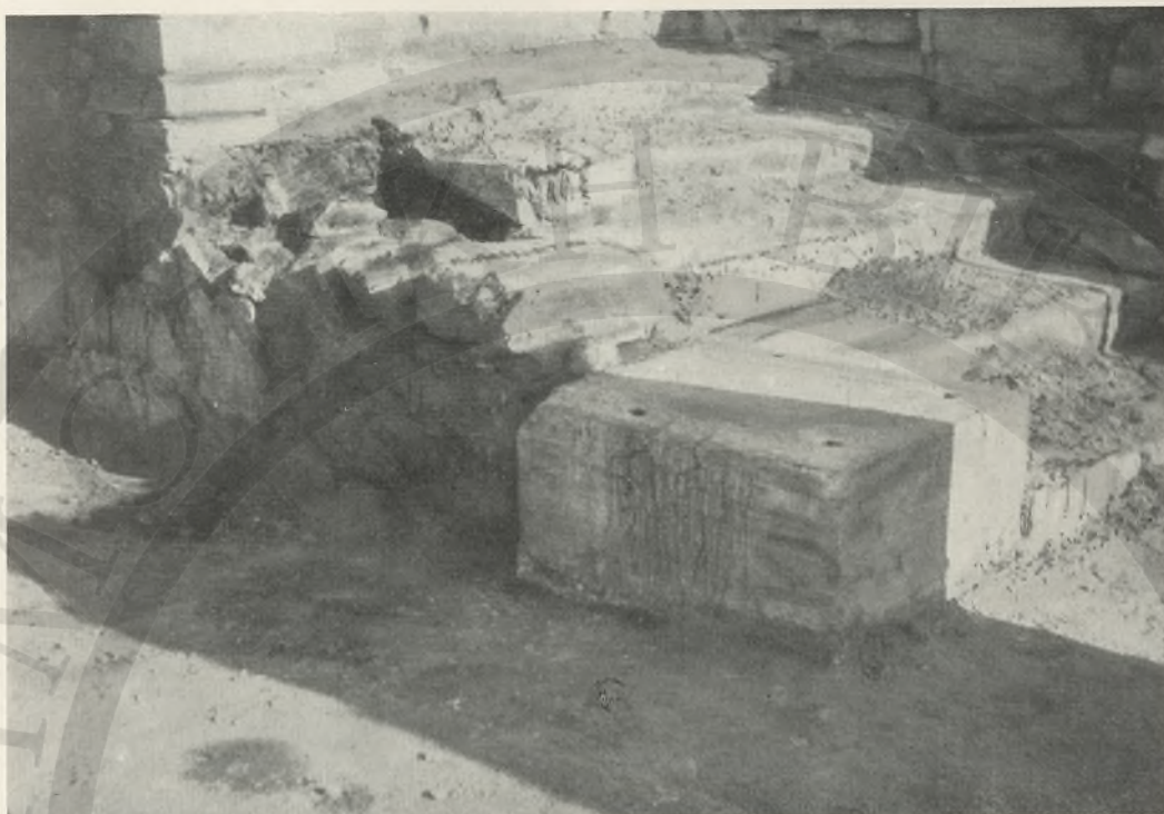
FIG. 176 - SCALA 76 DURANTE IL RESTAURO (SI NOTI IL GRADINO TRIANGOLARE)
