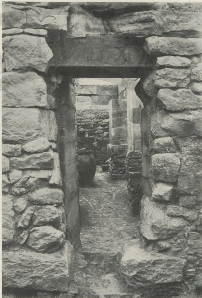
FIG. 51 - MODERNA APERTURA NEL MURO NORD DEL VANO 38 PER L'ACCESSO AI MAGAZZINI DEL PRIMO PALAZZO
