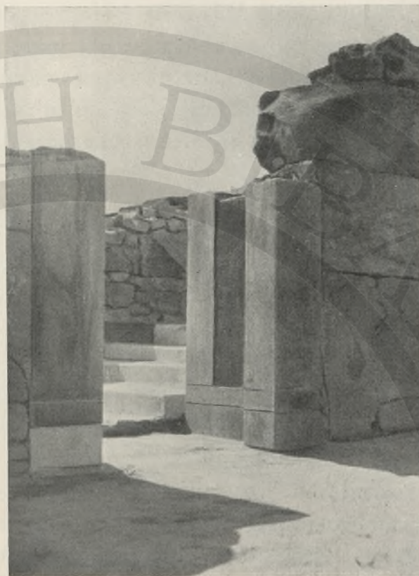
FIG. 35 – PORTA 40-39 DAL CORTILE CENTRALE (restaurata)
