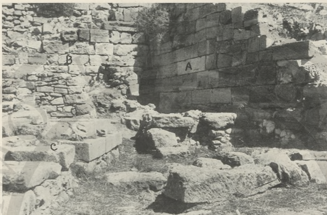
FIG. 83 - INCONTRO DEI DUE MURI DI SOSTEGNO NORD-SUD (A) E EST-OVEST (B); C, TEMPIO ELLENICO
