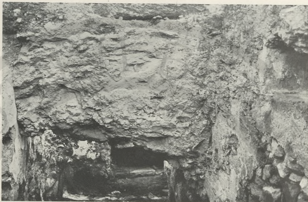
FIG. 3 - LA GETTATA DI CALCESTRUZZO SUI VANI DEL PRIMO PALAZZO
