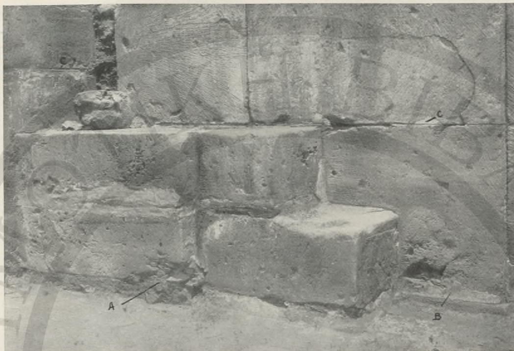
FIG. 21 - CORTILE CENTRALE, COSTRUZIONE ALL'ANGOLO NORD-OVEST: A, ANTICA ACCOMODATURA; B, RACCORDO A SGUSCIO FRA MURO E PLINTO; C, LINEA SEGNATA NELLO STUCCO
