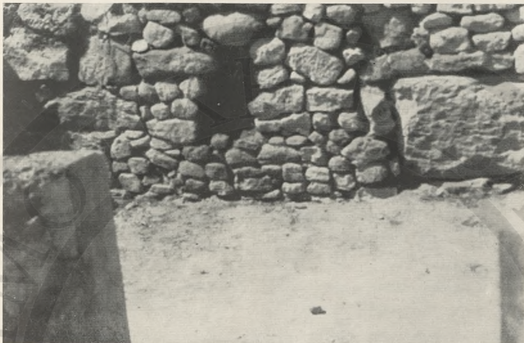
FIG. 279 — VANO 82: APERTURA AD ARCO NELLA PARETE OVEST
