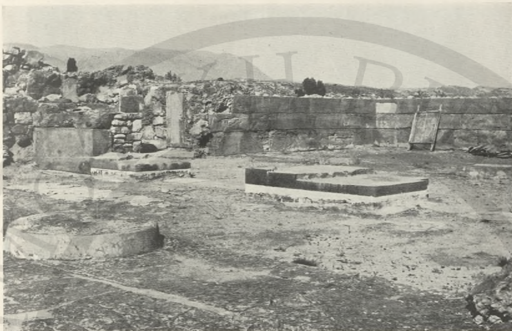
FIG. 190 — PORTICO 68: PILASTRO CENTRALE E ANTA SUD DELLA PORTA 68-69 RESTAURATI
