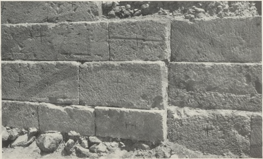
FIG. 7 - MURO DI FONDO DELLA GRADINATA 4
