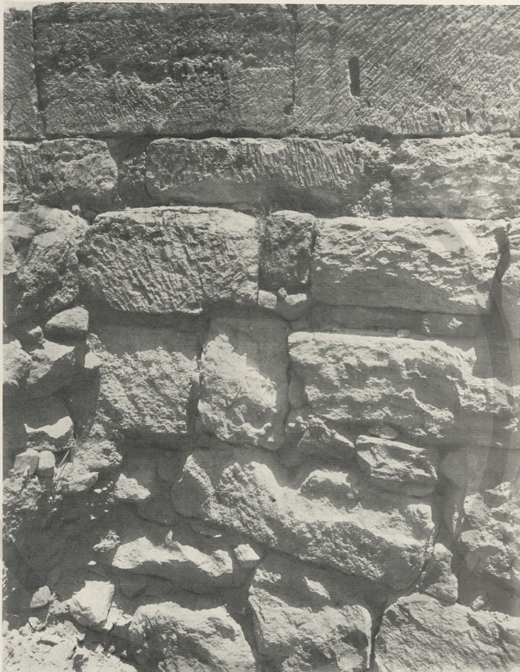
FIG. 271 - FACCIATA OCCIDENTALE: LE FONDAMENTA
