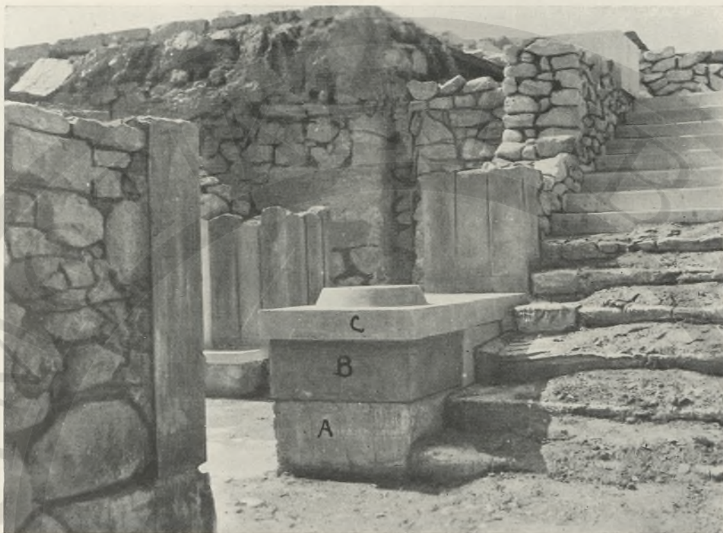
FIG. 175 - SCALA 76: A, BASE IN GESSO; B, COSTRUZIONE IN LEGNO E MURATURA, C, DAVANZALE A MATTONI CRUDI
