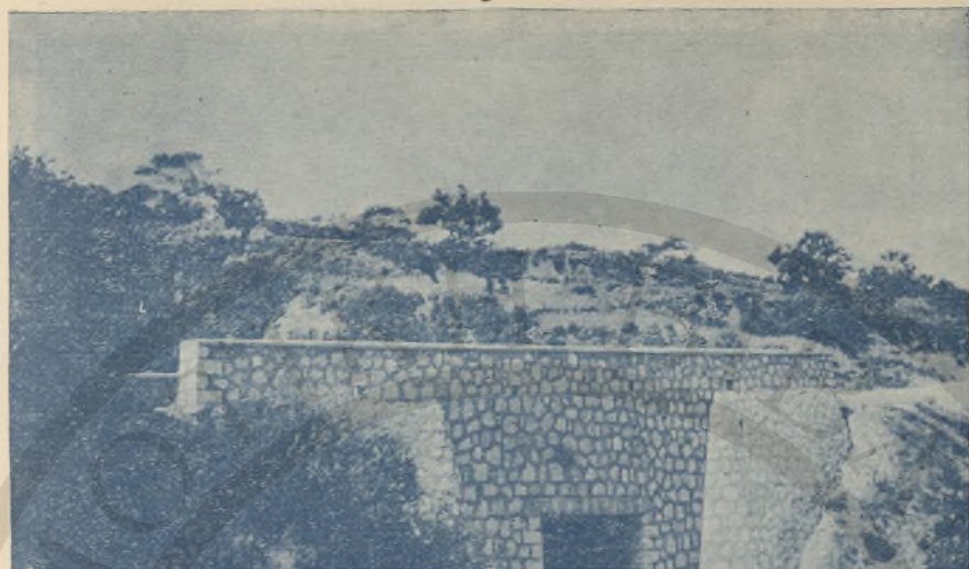
Γέφυρα «Λαγκάδες» ἐπὶ τῆς Ἐπαρχιακῆς ὁδοῦ Ἀχλάδα—Παρασπύρι Νομοῦ Λασηθίου. (*Ἔργα ὁδοποιίας Νομοῦ Λασηθίου).
