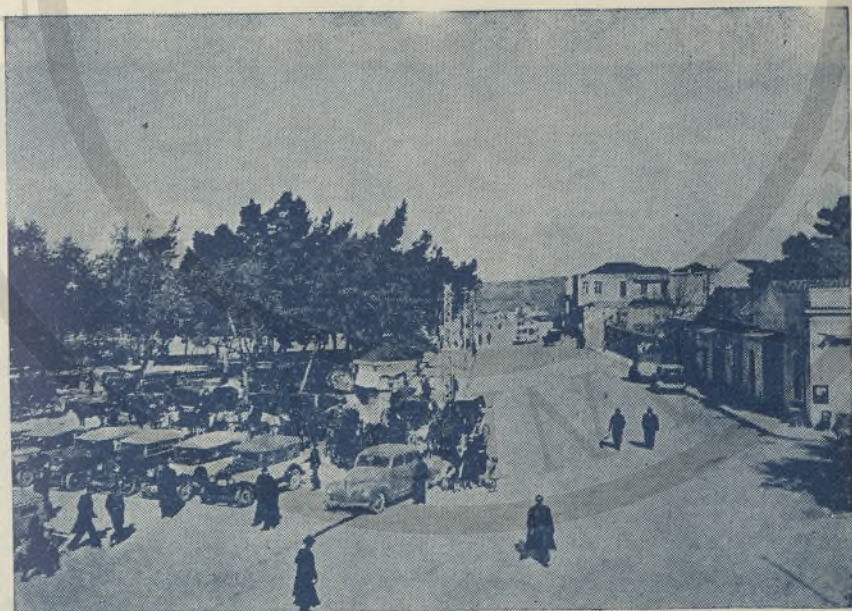
Ρυμοτομία τῆς Δυτικῆς πλευρᾶς τοῦ Γυμνασίου Ἀρρένων, κατεδάφισις ὑποστέγου ὄγκου 1300 κυβ. μέτρων τῆς ἐνώσεως γεωργικῶν Συνεταιρισμῶν καὶ ἄλλων παραπηγμάτων πρὸς δημιουργίαν Πλατείας ἀνατολικῶς τῆς Δημ. Ἀγορᾶς ἐκτάσεως 5.000 τ.μ. Ἡ ἐργασία ἐξετελέσθη τὸν Δεκέμβριον 1938.
