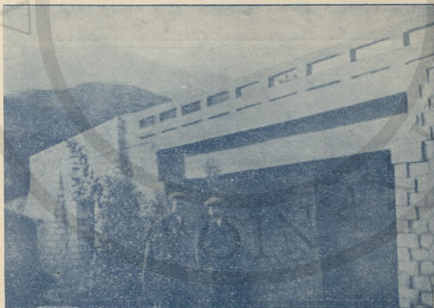
Γέφυρα ἄρτι ἀποπερατωθεῖσα ἐπὶ τῆς Ἐπαρχιακῆς ὁδοῦ Ἱεραπέτρας —Ἀνατολῆς Λασηθίου. (*Ἔργα ὁδοποιίας Νομοῦ Λασηθίου).
