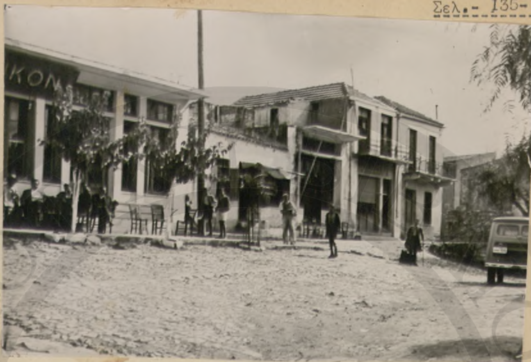
Οικοδόμησις οίκων ὑπὸ τοῦ Ἐπιχειρηματικοῦ Ἐπιχειρηματισμοῦ. Τὸ λευκὸν κτίριον εἶναι Ἐλαιοτριβεῖον.
